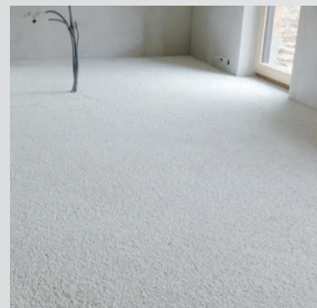
ThermoWhite fertig abgezogen
